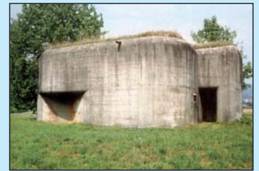
Ein Werk der Maginot-Linie im Nord-Elsass. Die Maginot-Linie entlang der französischen Nord- und Ostgrenze wurde von 1930 bis 1936 gebaut.
